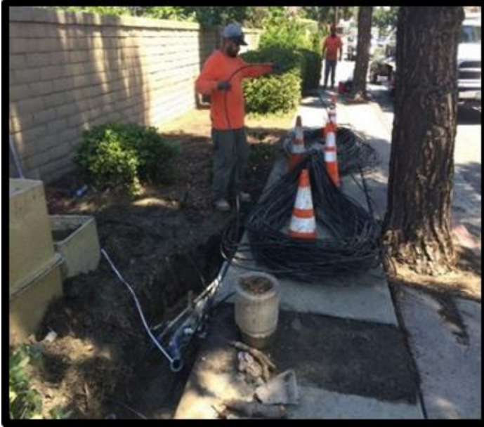
Conduit Repair
