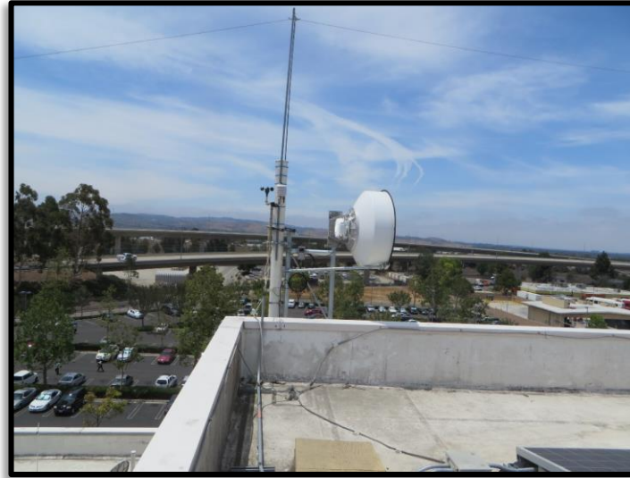
D12 TMC Roof Antennae
